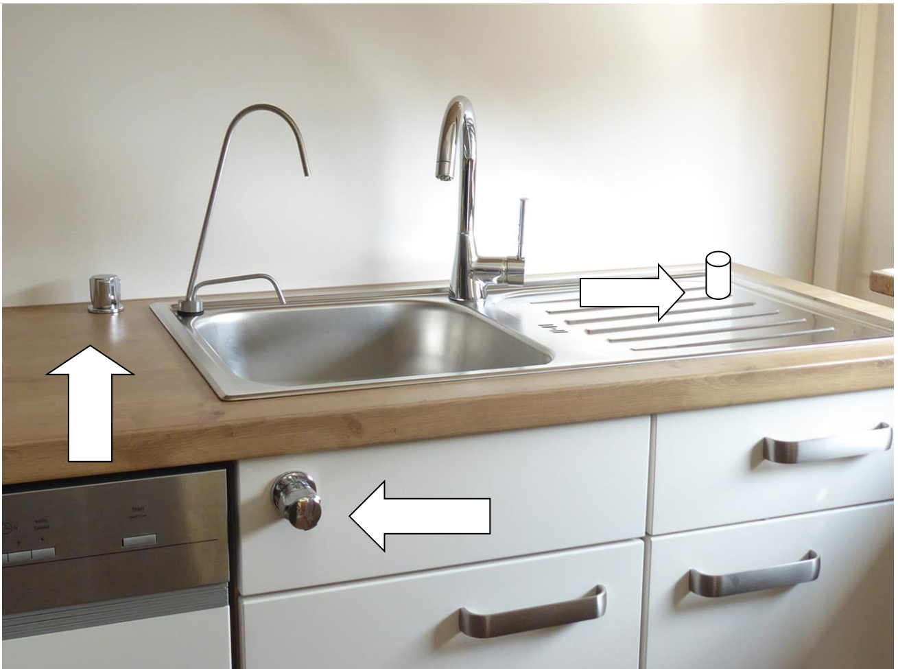
Abb.: Beispiele für den Einbau eines Durchführungs-Ventils.
